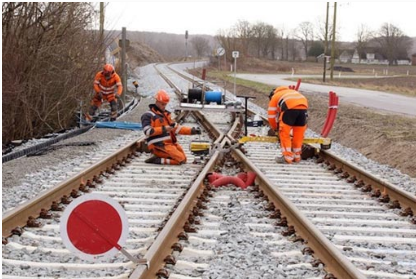
Sikringstjenesten trækker kabler.
