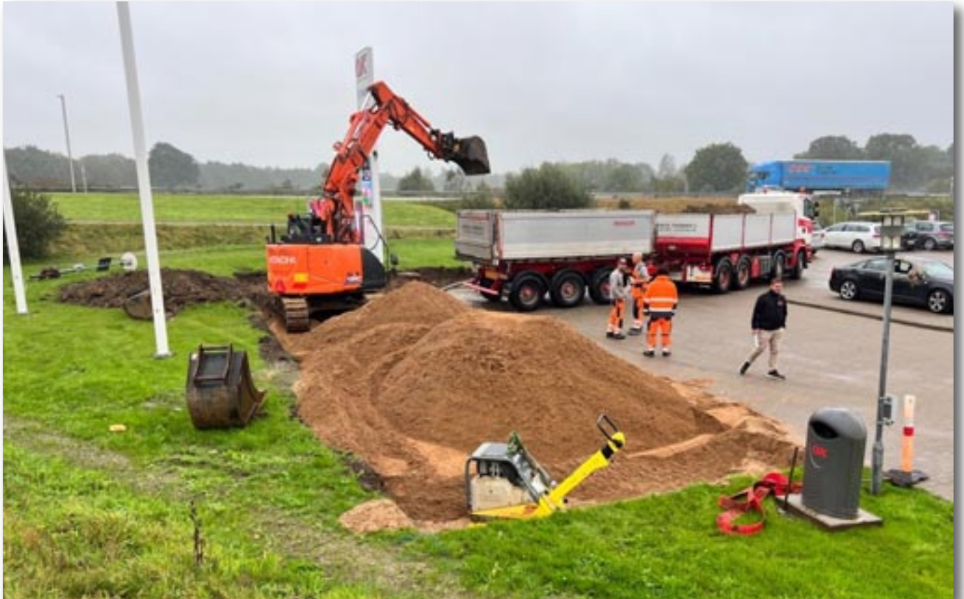
Gravearbejdet er begyndt ved den første lokation på Lysbjergvej i Vojens.
