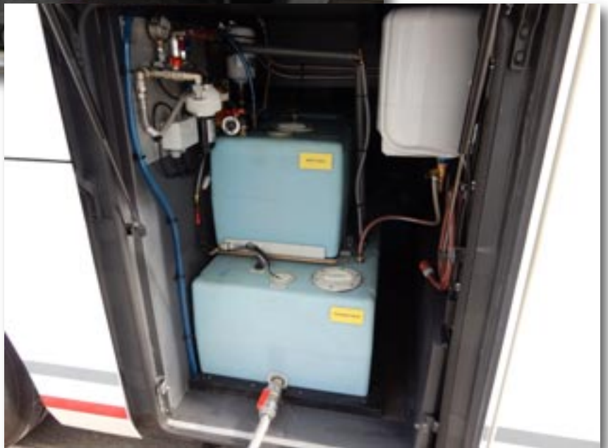
Vandtanke og varmekedel.
