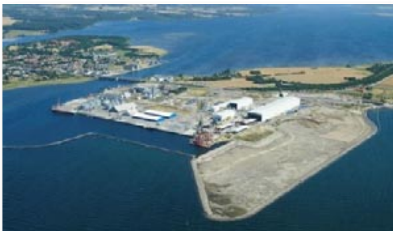
Vordingborg Havn og brobyggepladsen åbner for adgang. (Foto: Vejdirektoratet)
