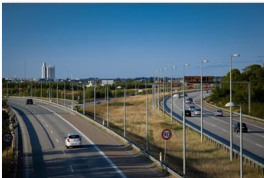
De kommende år bliver 18.000 LED-lamper installeret på lygtepæle langs statsvejene. (Foto: Daniel Fogh/Andel Lumen)
