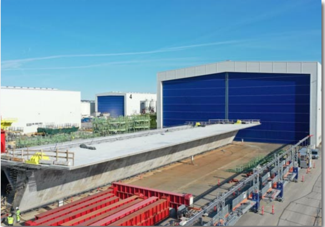
Det første præfabrikerede brodragerelement er trukket uden for hallen. Foto: Vejdirektoratet.
