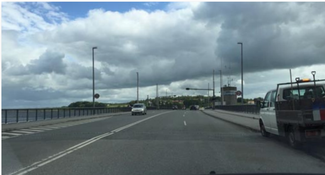
Hadsundbroen er en af de broer, der skal vedligeholdes i 2021.
