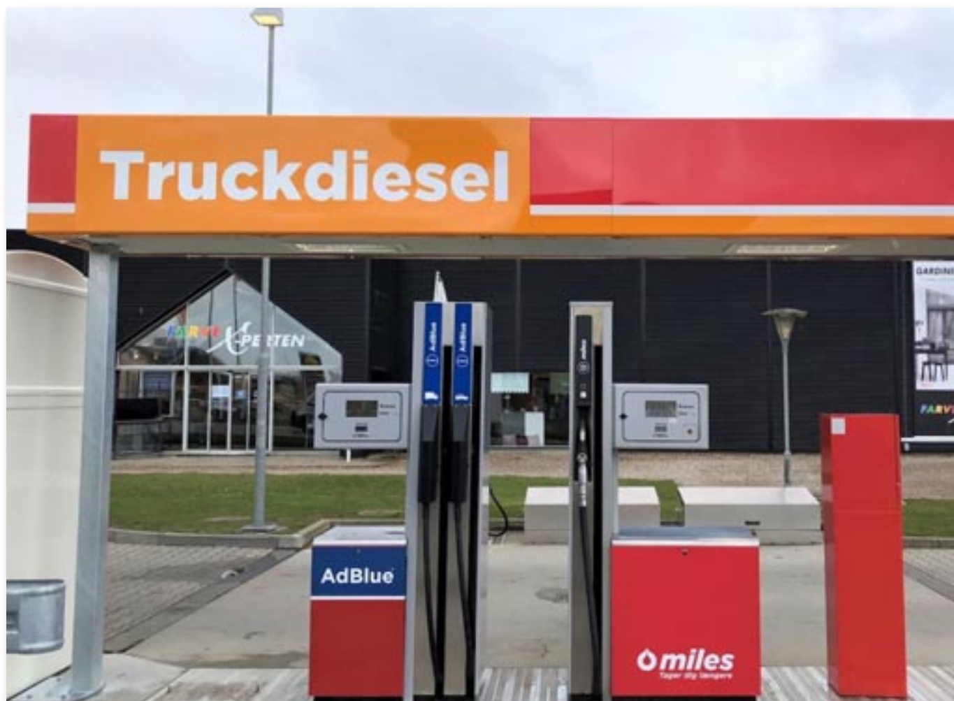
Truckanlægget i Ringe.
